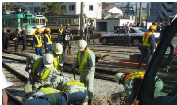
2017年度 事故訓練（総合脱線復旧訓練）
